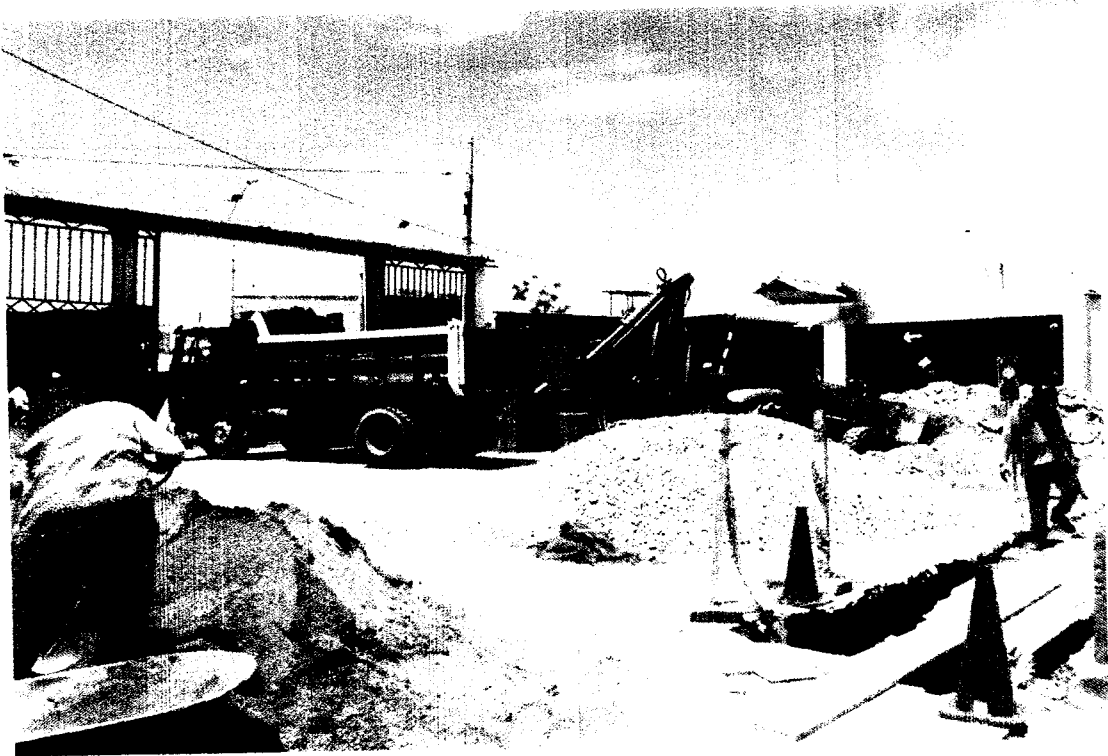
Fotografia N° 01. Se realizan los trabajos de eliminacion de material excedente
